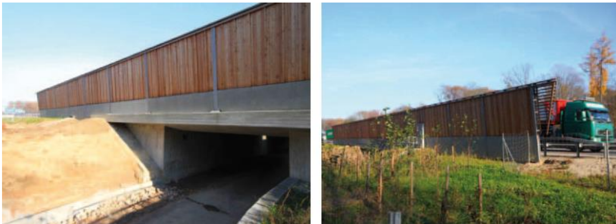
Abb. 3: Beispiel für Irritationsschutzwände (BAB A 5 bei Offenburg). Die Sperreinrichtung reicht ca. 25 m über das Bauende des Wildtierdurchlasses (hier kombiniert mit einem Radweg) hinaus. Die Weite (8 m) und Höhe (ca. 3 m) lassen eine Annahme durch die meisten strukturgebunden fliegenden Fledermausarten erwarten. Auf dem Bild fehlt noch die geplante und zwingend erforderliche Bepflanzung als Leitstruktur (Quelle: BRINKMANN et al. 2012).
