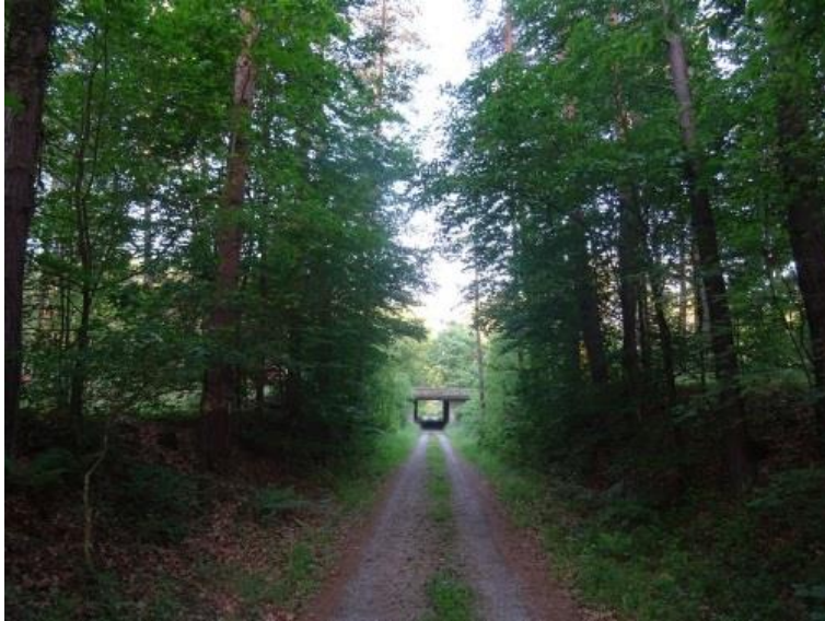
Foto 7: Waldwegunterführungen – wie hier zu sehen – sind wichtige Querungsmöglichkeiten für Fledermäuse an der B 469.
